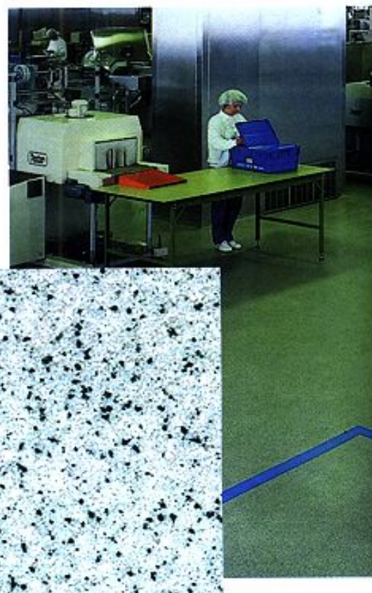
Bild 2: Der Pharma-Terrazzo besteht aus wasserklarem Epoxidharz und farbecht mit Polyurethanharz gecoateten Granulaten
