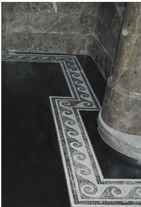
Sanierung Preysing Palais, HypoVereinsbank, München
