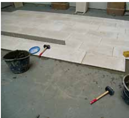
Belegung Vitmolit mit Naturstein nach 12 Stunden.
