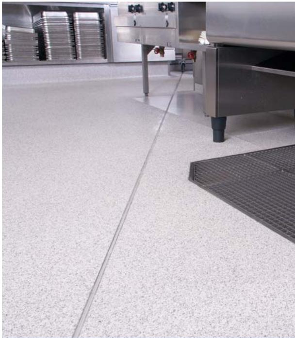
Baudehnungsfugen werden in Kunstharzbeton eingebaut.
