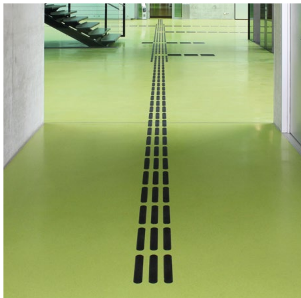
Nachträglicher Einbau in der TU Dresden
