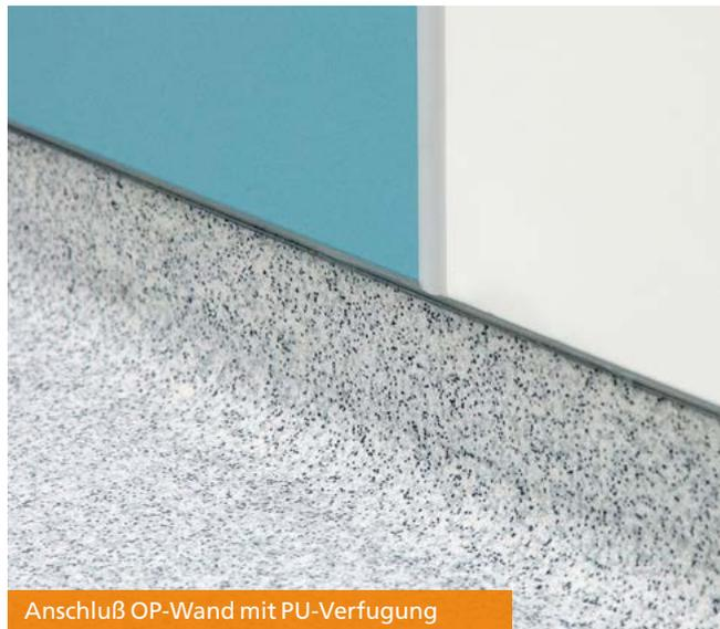
Anschluß OP-Wand mit PU-Verfugung
