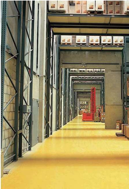
Обойная фабрика «Marburger Tapetenfabrik GmbH + Co. KG», Кирххайн
