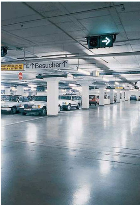
Подземный гараж «Tiefgarage Allianz AG», Штуттгарт
