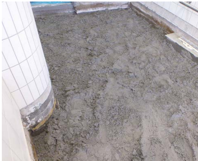
Einbau eines Verbundestriches im Grossküchenbereich
