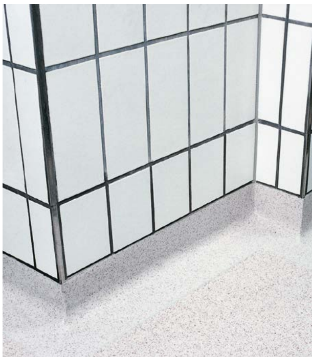
Hohlkehlen im Verbund werden in einer glatten Oberfläche an Fliesen angearbeitet.
