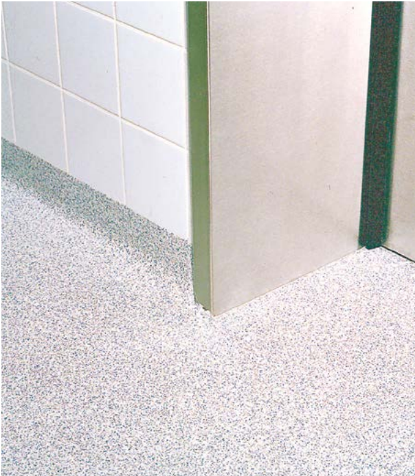
Anarbeitung einer Hohlkehle an eine OP-Türzange
