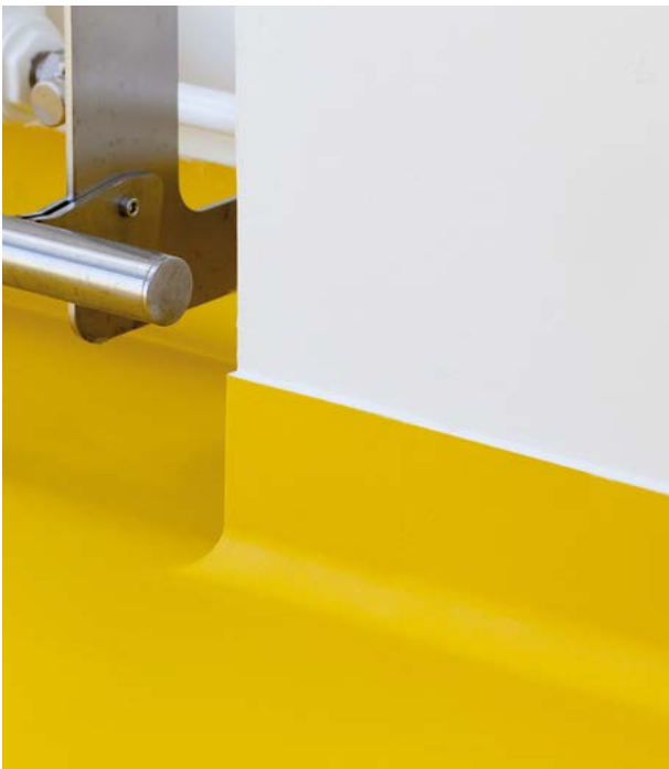
Hohlkehlen werden exakt von Hand an die Pharma-Reinraum- bzw. OP-Wand angearbeitet.
