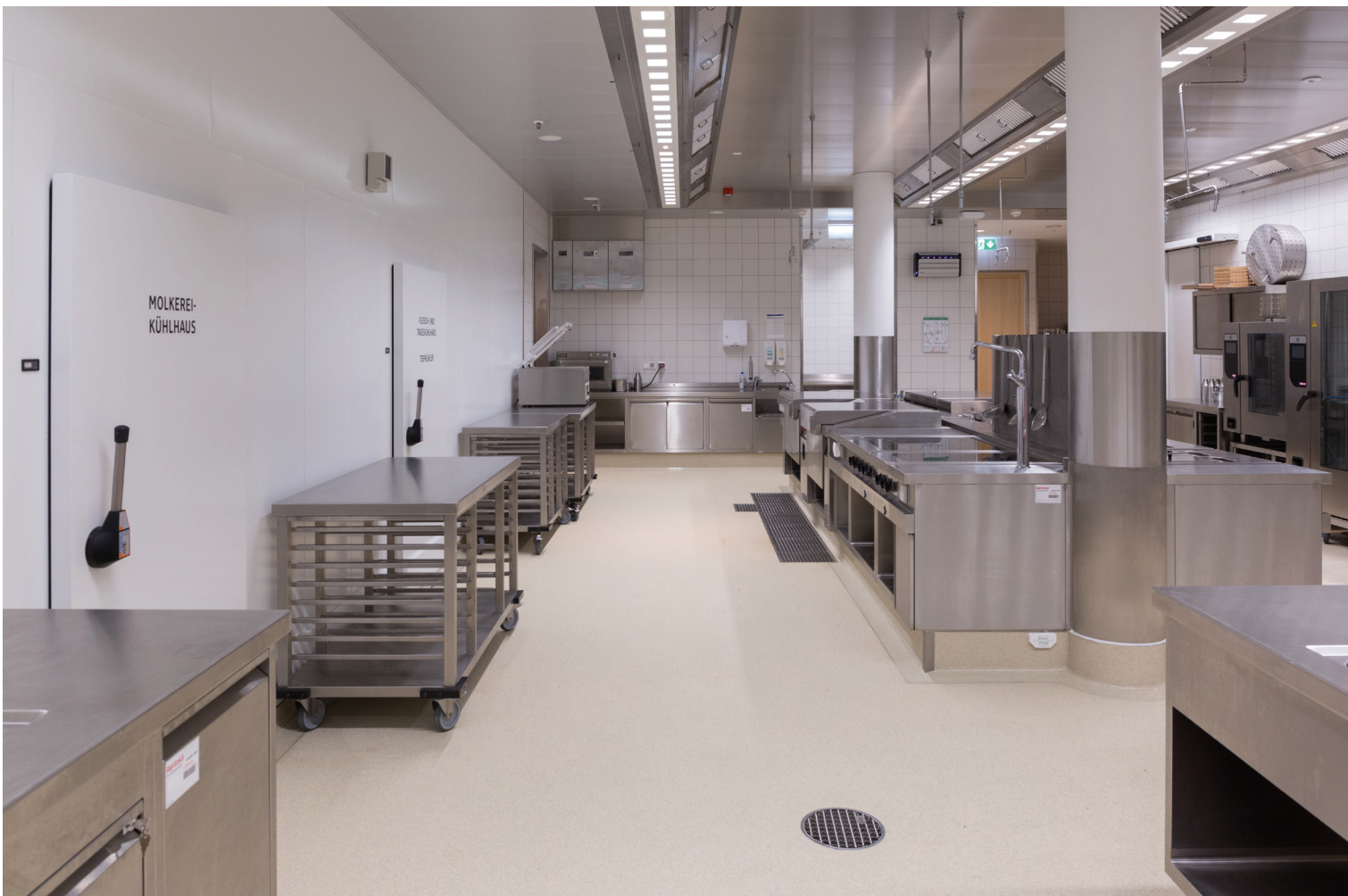
Der rutschhemmende BARiT Küchenboden in R 12 V 4 sorgt für die Anforderung der Unfallverhütung in Großküchen und nassbelasteten Flächen.
