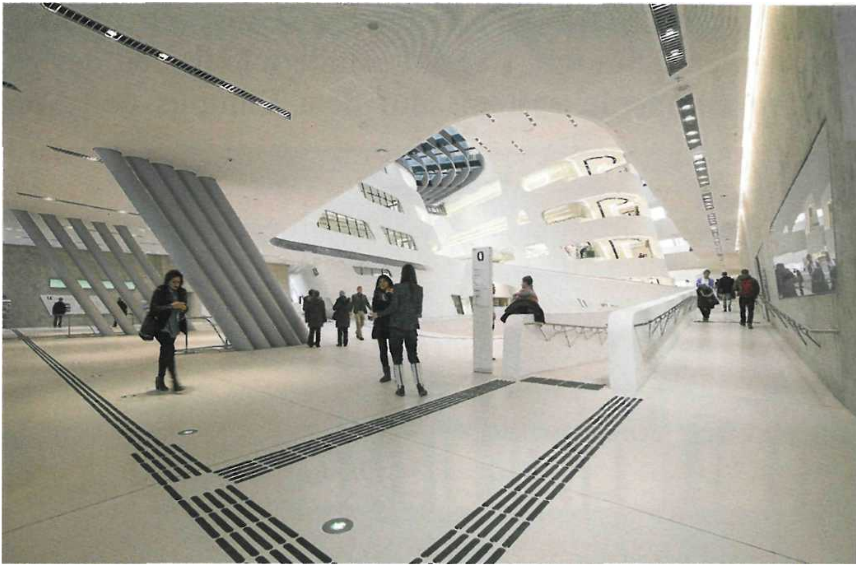
Bild 3. Schwarze taktile Bodenindikatoren in 3 mm Höhe bilden ein Leitsystem, das durch den Tastsinn erschlossen werden kann und so Sehbehinderten als Teil des gesamten Blindenleitsystems auf dem Campus den Weg weist (Fotos 1-3: BOAnet.at)
